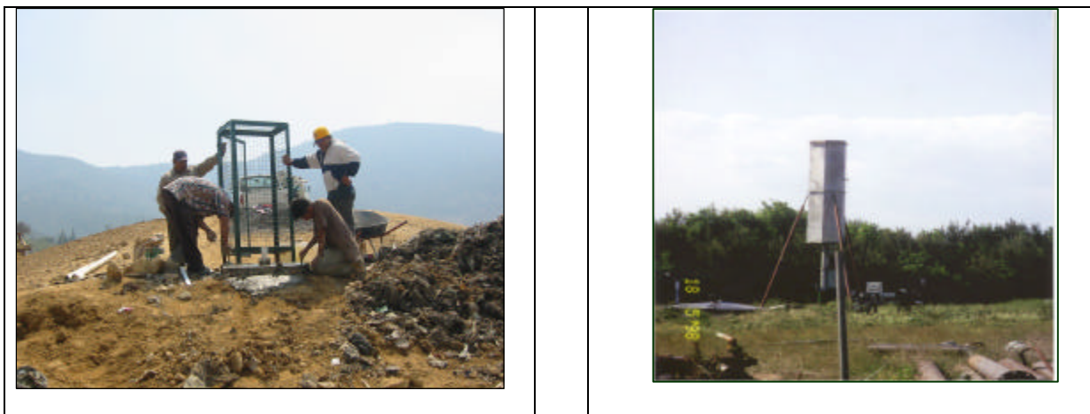
Figura 8 y 9: Quemador simples de biogás y Quemador centralizado (Fotografías: G. Wehenpohl)
